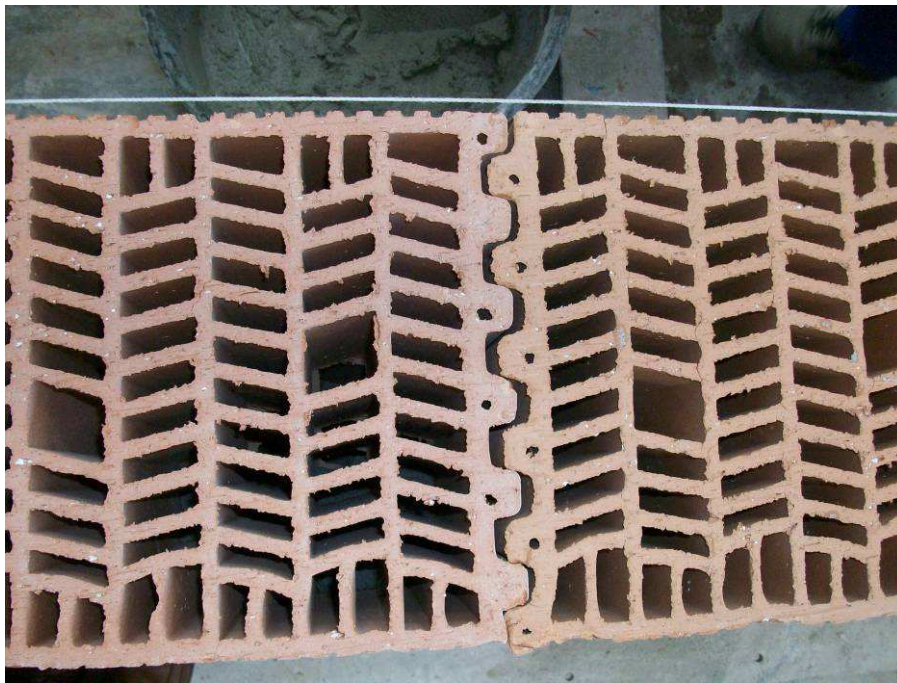
Figura 1– Detalle de la unión vertical entre bloques
