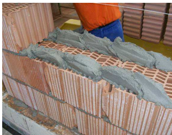
Figura 2 – Detalles de la junta horizontal
