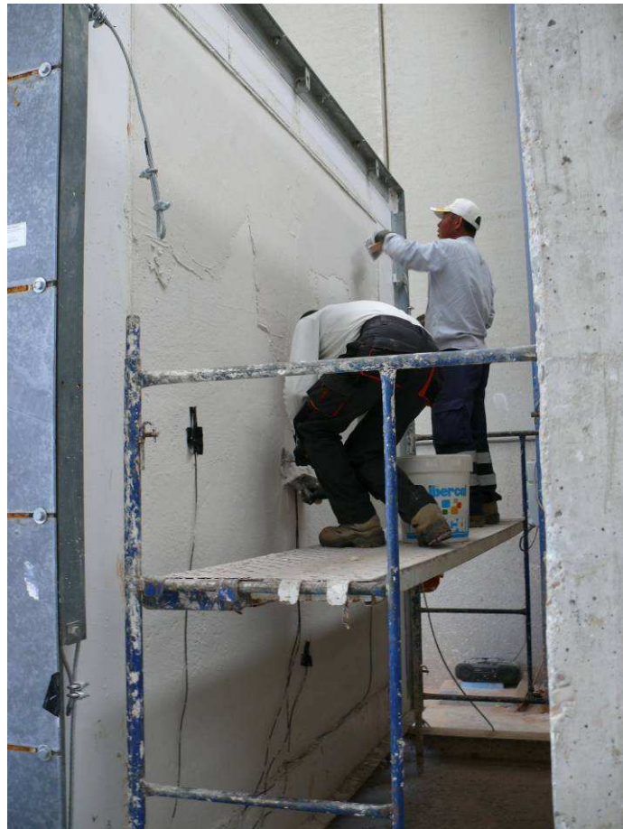
Figura 5 – Raseo de mortero magro por la cara exterior
