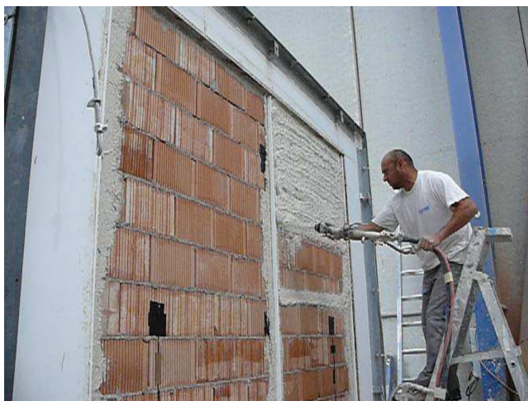
Figura 4 – Proyección de Thermocal
