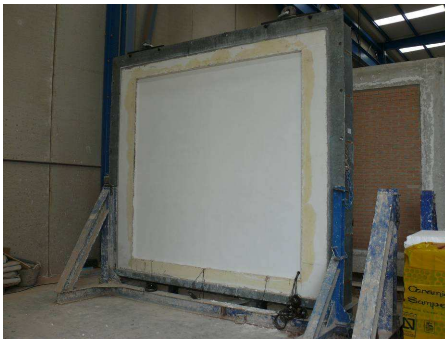
Figura 6 – Enlucido de masilla de cal por la cara interior
